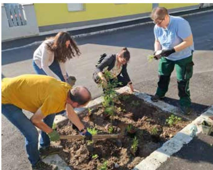
Für die Versickerungsflächen kam ein spezielles Draingarten-Substrat zum Einsatz, das eine besonders gute Wasserdurchlässigkeit gewährleistet. Es speichert Regenwasser pflanzenverfügbar im Boden, wodurch die Vegetation auch in Trockenperioden gut versorgt bleibt und das Wasser langsam in tiefere Bodenschichten versickern kann.
